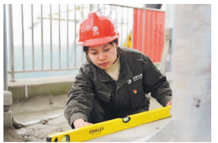
徐颖雪在500千伏金山变电站测量设备基础水平度。
