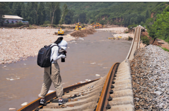
8月3日,京承铁路部分路段因暴雨受损,《中国日报》记者武晓慧在河北兴隆铁路受损段采访。那子鸣 摄
